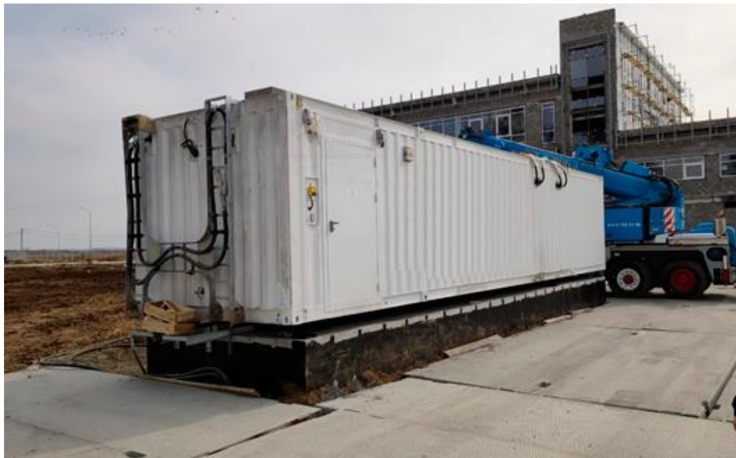
Установка КЦОД на площадку
