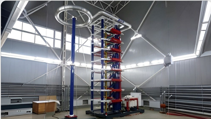
Генератор грозовых импульсных напряжений до 1600 кВ
