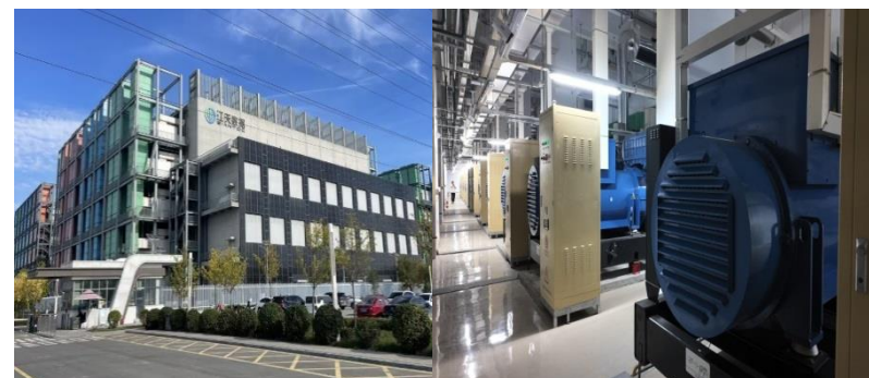
ЦОД Jiangtian 117*2000kW (высоковольтные установки)
