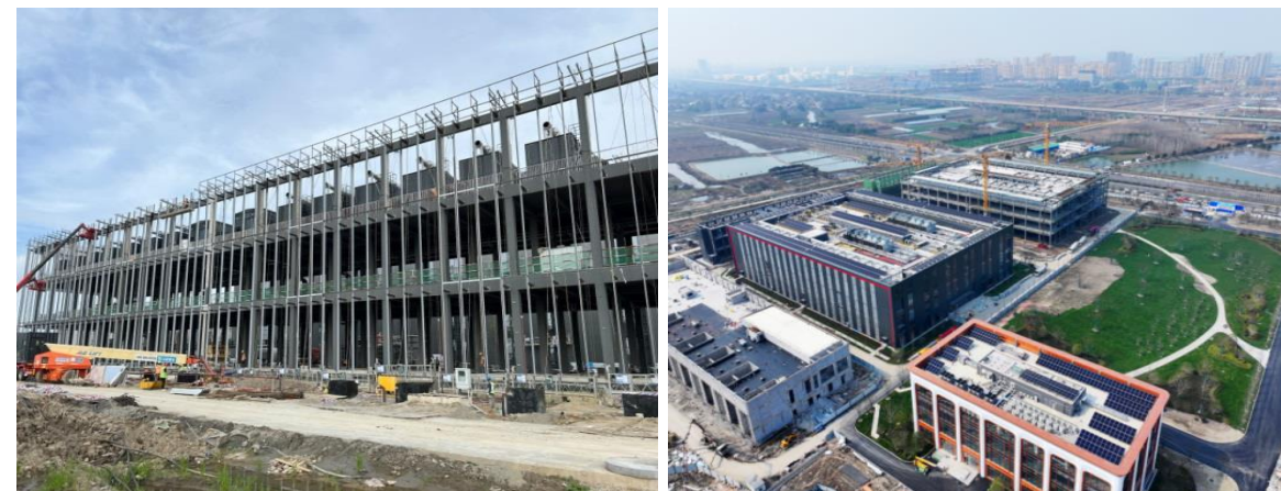
Вуху (Wuhu), Восточный Китай — высоковольтные контейнерные установки YC16VC мощностью 1800 кВт, всего поставлено 82 единицы.
