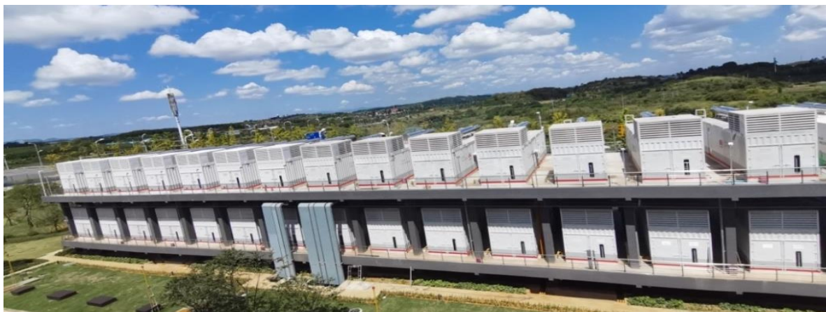
Гуань (Gui'an) High-End Park Data Center — высоковольтные контейнерные установки YC16VC мощностью 1800 кВт, всего поставлено 278 единиц.
