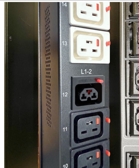
C19, C13, C39 с фиксаторами Перфорация на корпусе
