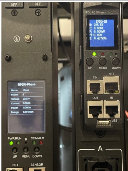
Съемный модуль мониторинга с возможностью горячей замены
