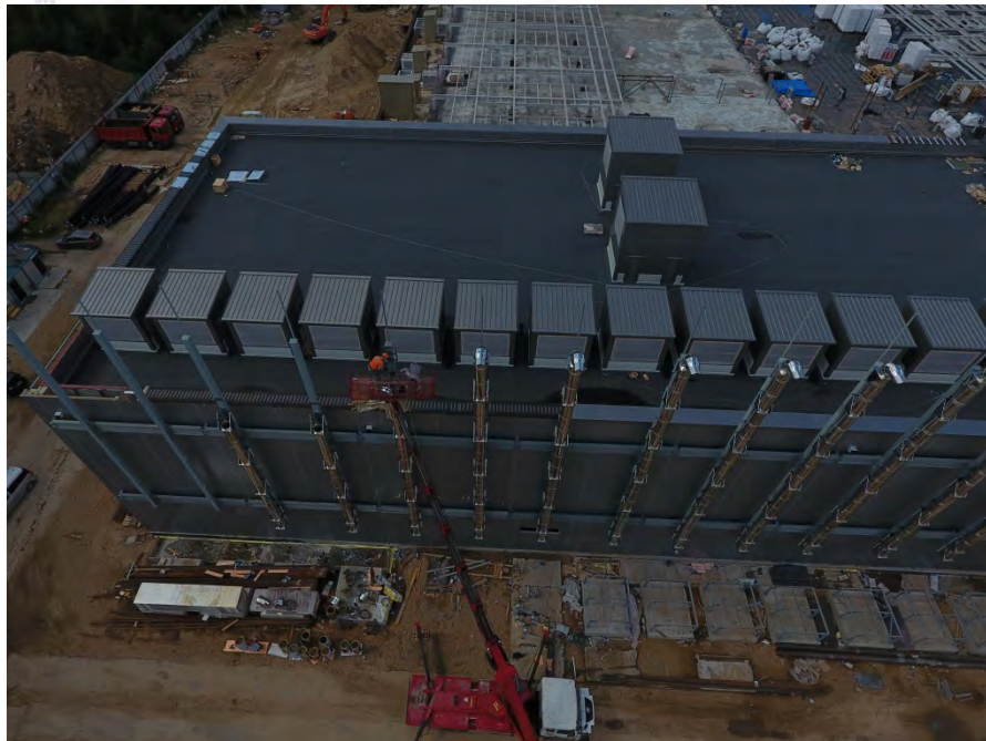
Здание энергоцентра с воздуха
