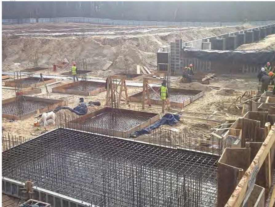
Подготовка фундамента здания дата-центра
