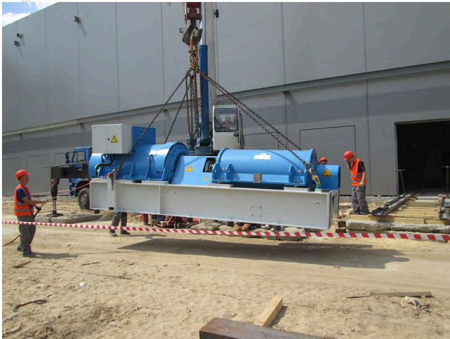
Разгрузка кинетического модуля дизель-роторного ИБП Hites
